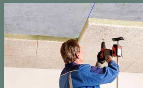
Für die Montage der Zweischicht-Dämmplatte Tektalan A2-SmartTec aus Steinwolle mit Holzwolle-Deckschicht reichen zwei Schrauben pro Platte.
