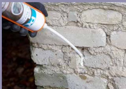
Injektion einer wasserabweisenden Horizontal-sperre mit PCI Barra Creme.
