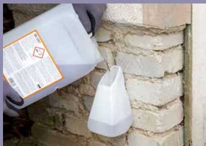
Mauerwerk mit der flüssigen Horizontalabdichtung PCI Barra Gisol gegen aufsteigende Feuchtigkeit schützen.
