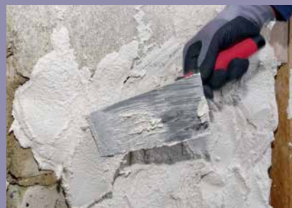
Aufbringen von PCI Saniment 2 in 1 als Sanier- und Feinputz in einem.
